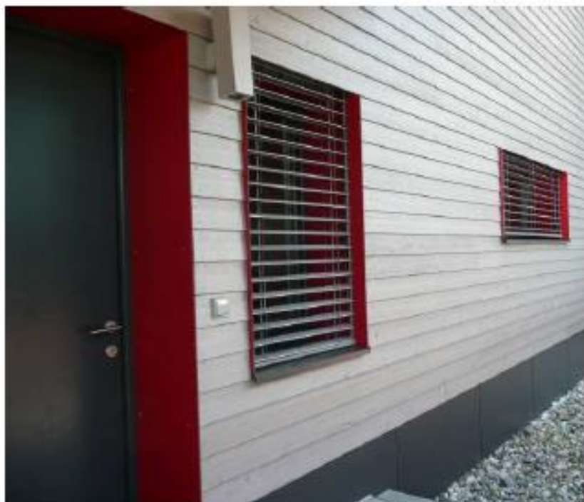
Figura 3.2. Edificio realizzato in legno con elementi protetti alla base e rialzati da terra
