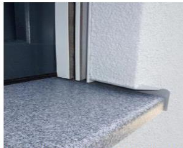
Abbildung 23: eingeputzte Sonnenschutzführungsschiene mit ausgeklinktem Endprofil. Zwischen Endprofil und Sonnenschutzführungsschiene ist eine Abdichtung z.B. mit Butyldichtbändern erforderlich.
