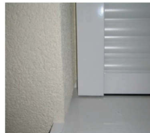
Abbildung 24: nachträglich montierte vorgesetzte Sonnenschutzschiene
