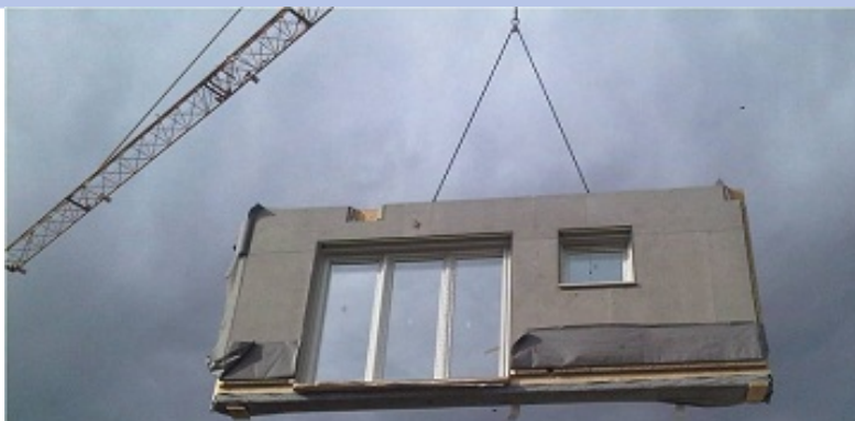
Utilizzo di pareti prefabbricate complete di serramenti
