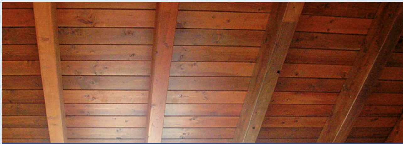
Impiego di "perline" nella realizzazione di un assito.
