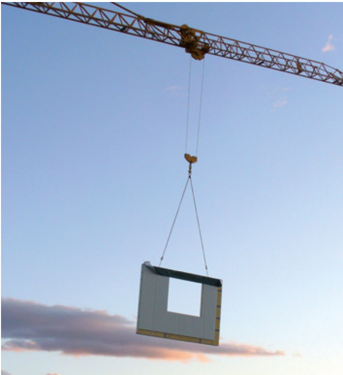
Parete prefabbricata di un edificio realizzato con il sistema costruttivo a telaio (timber frame), in fase di montaggio.
