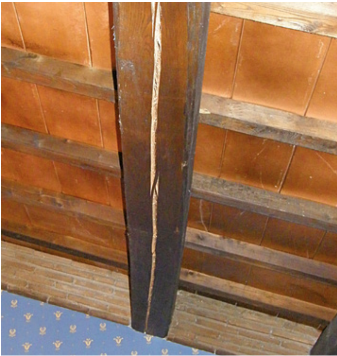
Trave portante di quercia, con tolleranza di smussi, di ottima qualità strutturale.
